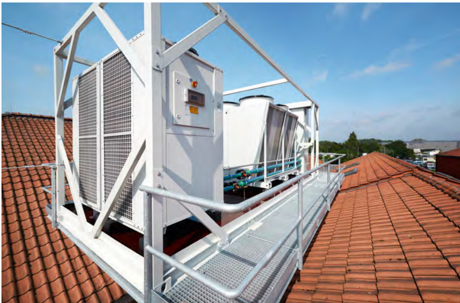
Eine Freikühlung – wie hier in einem Kühlcontainer auf dem Dach – ist eine einfache Option, die sich schnell rentiert.
